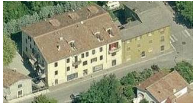
NUOVO MAGAZZINO NEW WAREHOUSE
