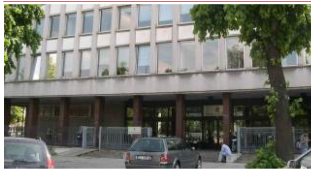
APPALTO PER L'ESERCIZIO, LA GESTIONE E LA MANUTENZIONE DEGLI IMPIANTI TERMICI, INCLUSA FORNITURA COMBUSTIBILE E DEI DISPOSITIVI ANTINCENDIO AFFERENTI GLI IMMOBILI DI PROPRIETÀ DELL'AMMINISTRAZIONE PROVINCIALE DI VERONA HEATING PLANT OF BUILDING IN VERONA
